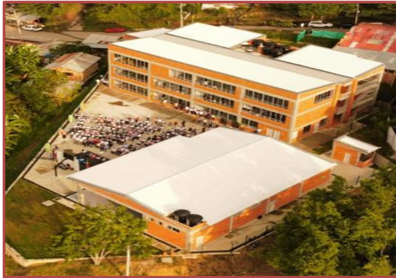
Municipio de Tena Construcción de la IED Fidel Cano Se beneficiarán 729 estudiantes.
