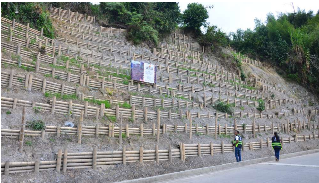
Obras de bioingeniería UAEGRD, Municipio de La Palma - Fuente: Archivo fotográfico - UAEGRD
