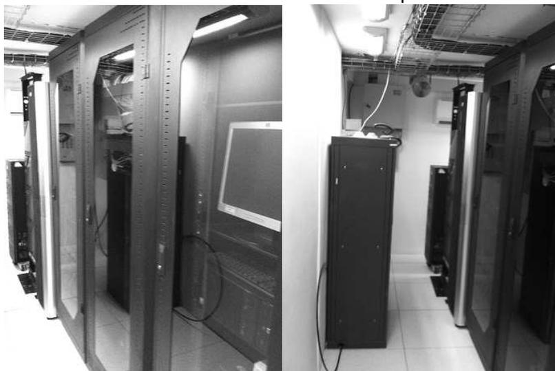
Para mejorar las condiciones de la plataforma tecnológica se adecuó un datacenter y se instaló cableado categoría 6A que cumple las normas internacionales para el mantenimiento de los equipos y el mejoramiento de las comunicaciones.
