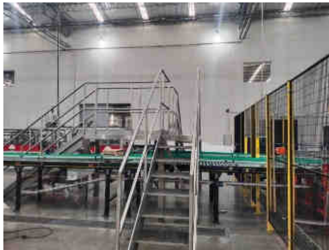
Plataforma de acceso operacional final líneas 1 y 2
