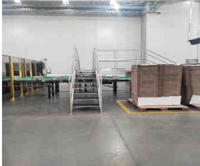
Plataforma de acceso operacional final líneas 8 y 9
