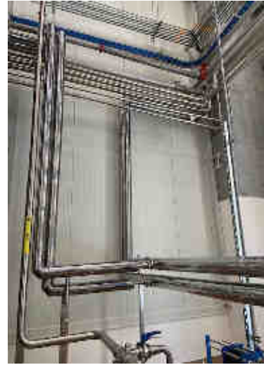
Conexión de tubería de glicol y nuevo bypass proceso elaboración de rones
